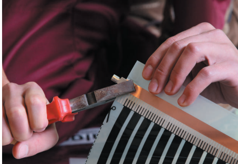
Рис. 10. Крепление контактного зажима к термопленке
