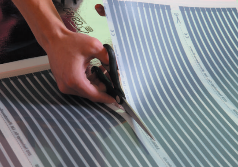
Рис. 7. Разрезание термопленки CALEO по линиям отреза
