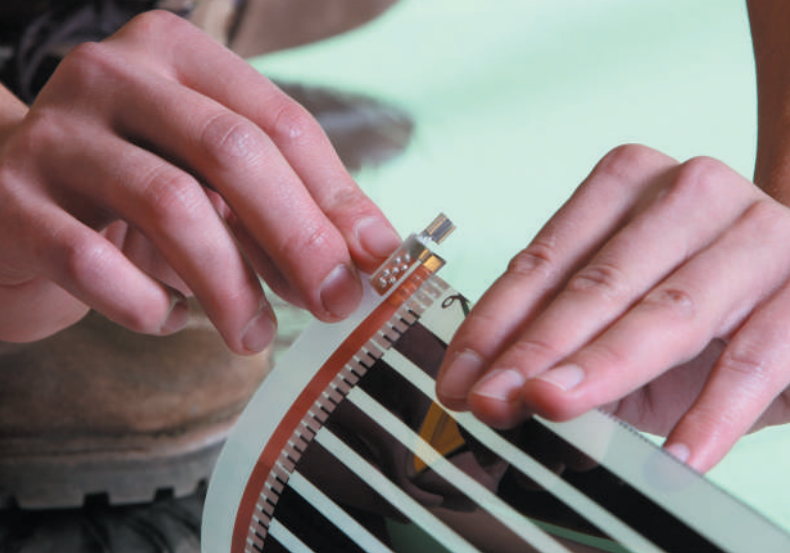
Рис. 9. Установленный на термопленку контактный зажим со стороны медной полосы (снизу)
