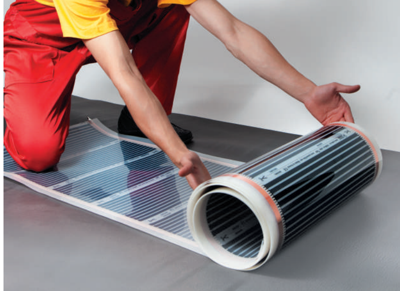
Рис. 5. Раскатывание рулона теплого пола на теплоотражающем материале
