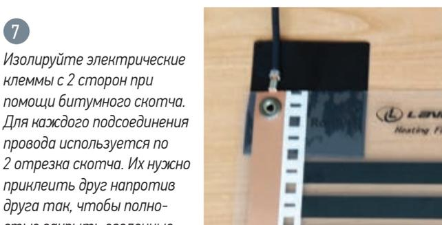
7 Изолируйте электрические клеммы с 2 сторон при помощи битумного скотча. Для каждого подсоединения провода используется по 2 отрезка скотча. Их нужно приклеить друг напротив друга так, чтобы полностью закрыть оголенные участки клеммы и монтажного провода и не допустить попадания влаги на место соединения. Также битумным скотчем следует изолировать противоположные концы медной шины (места отреза).
